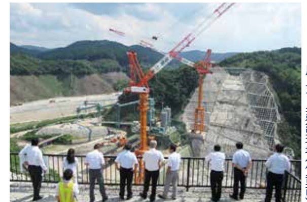
川上ダム建設現場(伊賀市)
