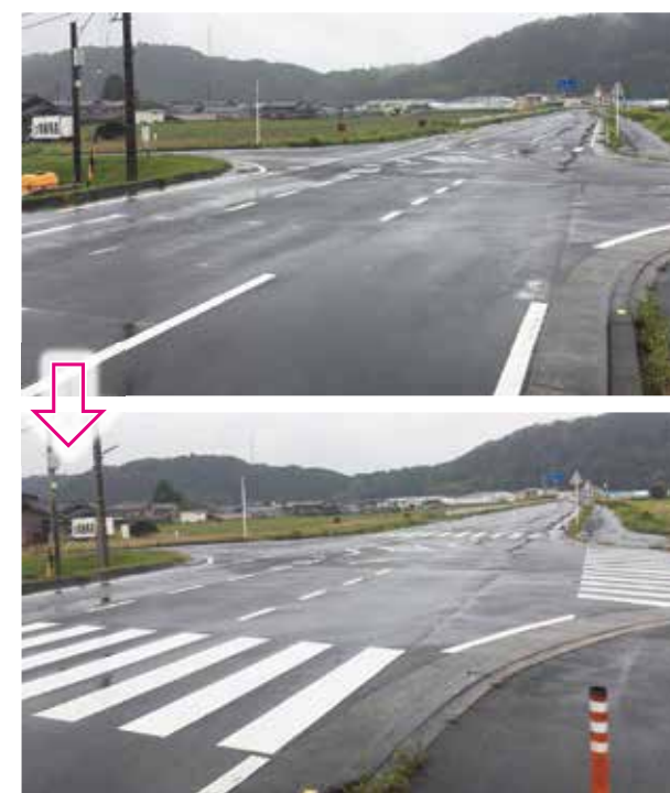
▲伊賀市青山羽根地内の白線塗り直し
